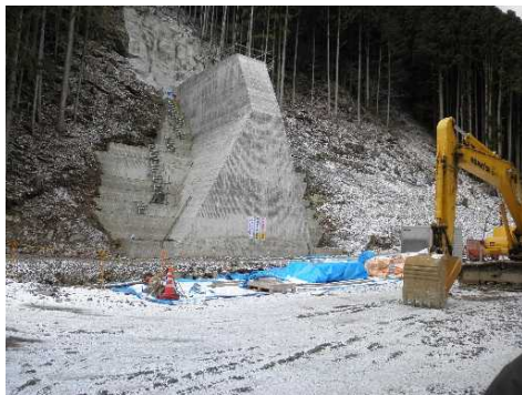
写真 1 3号砂防えん堤
