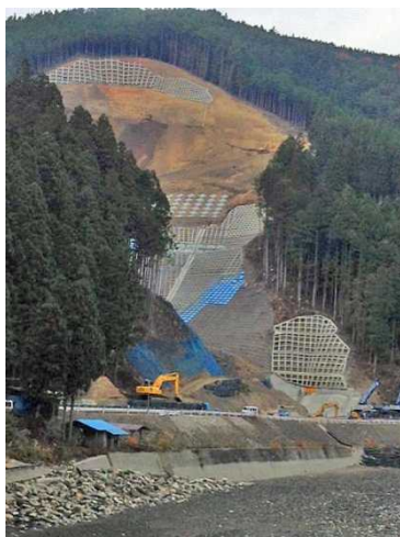
写真 3 芦ノ瀬谷復旧現場全景
