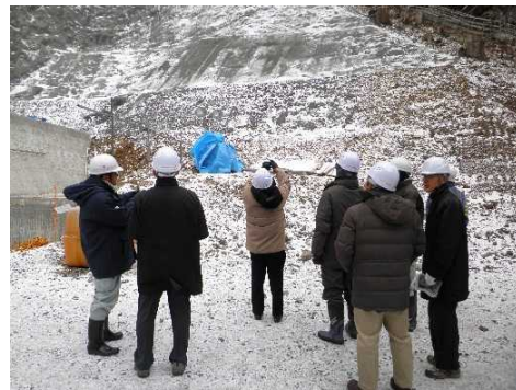
写真 2. 法面部村道付替え工事
