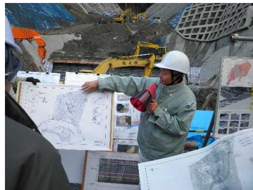
写真 4. 芦ノ瀬谷法面对策工の説明
