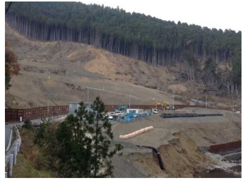
写真5、坪内地区現場全景
