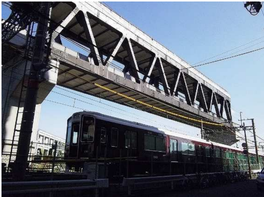
現地の状況写真
